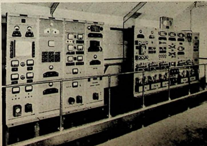
Englische Drahtfunk-Sendeinrichtung zur Übermittlung von Fernseh- und Rundfunkprogrammen (E. M. I. Relays (Hayes Ltd.)). Das linke Gestell enthält den Fernsehsendeteil, während die rechts sichtbare Anlage zur gleichzeitigen Übertragung von fünf Rundfunkkanälen eingerichtet ist.
